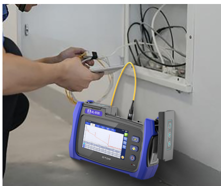
小区宽带施工
